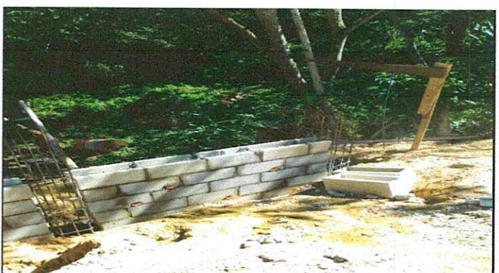
Foto 4: MEJORAMIENTO DE MURO DE CONTENCIÓN
