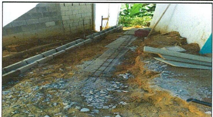
Foto 2: Mejoramiento de muro de Contención
