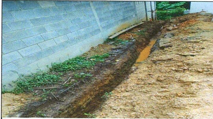
Foto 1: Mejoramiento de Muro de Contención
