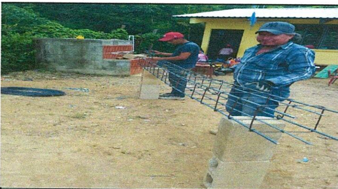
Foto 3: MEJORMIENTO DEL SANITARIO
