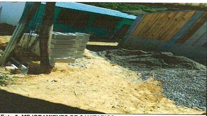
Foto 5: MEJORAMIENTO DE SANITARIOS
