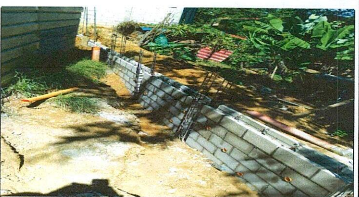
Foto 6: MEJORAMIENTO DE MURO DE CONTENCIÓN
